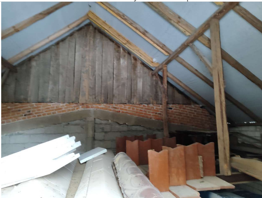
Foto 8 – Konstrukcja dachu nad garażem
